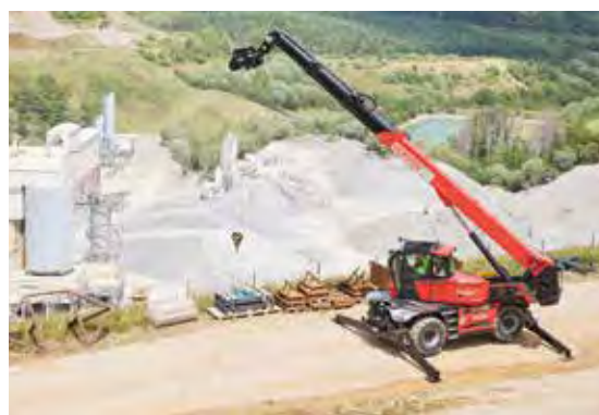
Zum Leistungsangebot von XERVON IPS gehört auch die Errichtung von Boosterstationen zur Entwässerung der Steinbrüche
