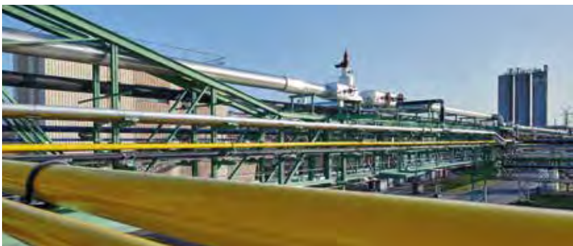
Das sanierte Rohrleitungsnetz, bei dem mehr als 20 verschiedene Dienstleistungen und acht Fachbereiche der REMONDIS-Gruppe Hand in Hand tätig waren
